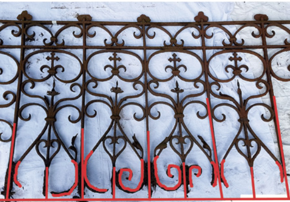
Kartierung der Substanzverluste
