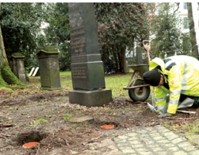
Bohrung der Punktfundamente
