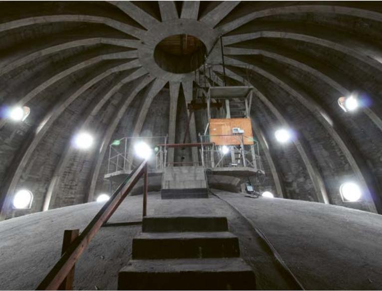
Die Auferstehungskirche in Barmbek hat zwei Eisenbeton-Kuppeln: Eine Rippenkuppel trägt das Dach und eine Schale deckt den Kirchenraum ab.
