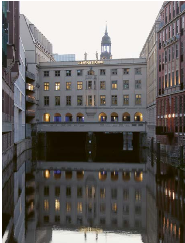
Das 1921 über dem Bleichenfleet vollendete Stadthaus erforderte technischen Aufwand: So sollte das Niveau der Erdgeschosses vom Neubau und seinen Nachbarn gleich bleiben. Damit aber war für die Durchfahrthöhe im Fleet und den Boden des Neubaus der Platz äußerst knapp. Foto: Sven Bardua, 2019
