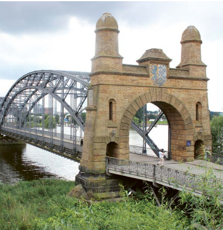
Die 1899 eingeweihte Alte Harburger Elbbrücke: Die Sandstein-Portale sind „Architektur“, die Brücke selbst ist „Ingenieurbaukunst“. Foto: Sven Bardua, 2016
