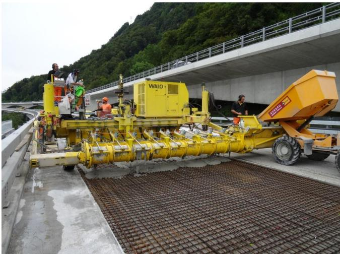
Abb. 6: Chillon-Viadukte: Maschineller Einbau des Frisch-UHFB
