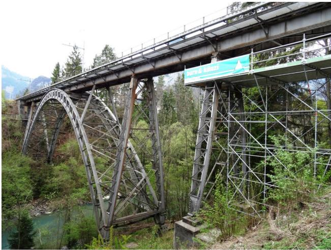
Abb. 2: Bahnbrücke über die Kander bei Wimmis (Schweiz), genietete Stahlkonstruktion, Baujahr 1897.
