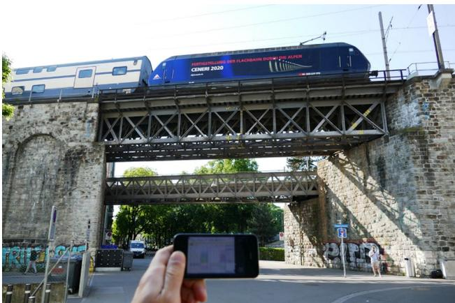
Abb. 3: Strassenunterführung des Wipkingerviadukts in Zürich (Schweiz), genietete Stahlkonstruktion, Baujahr 1896; Monitoring von Messwerten auf dem Smart Phone.
