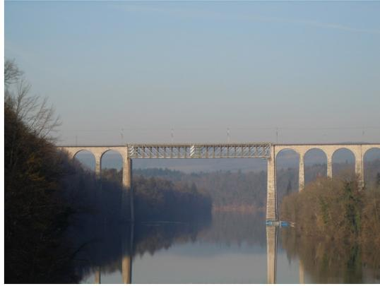
Abb. 1: Bahnbrücke über den Rhein bei Eglisau (Schweiz), 90m gespannte Flussbrücke in genieteter Stahlbauweise, Baujahr 1896.
