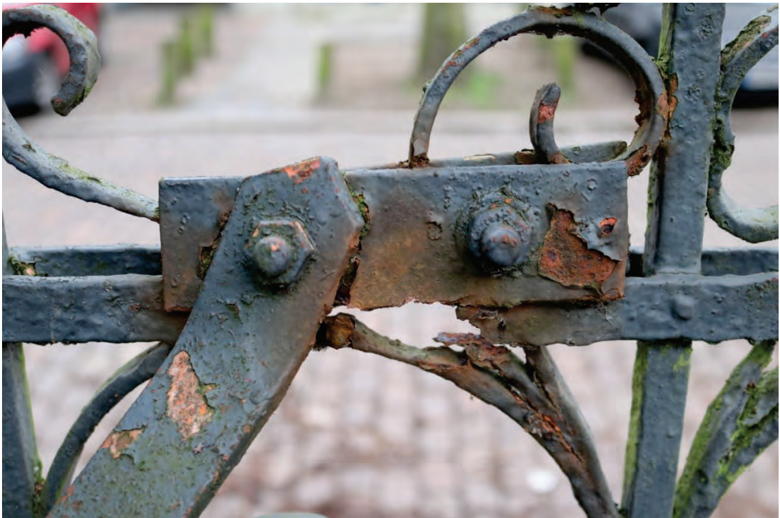
Abb. 138: Ansicht einer neueren Stützenbefestigung von der Parkseite
