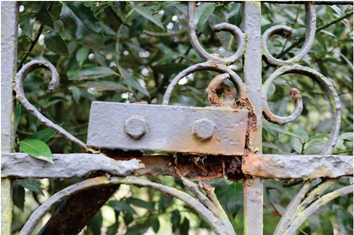
Abb. 137: Ansicht einer neueren Stützenbefestigung
