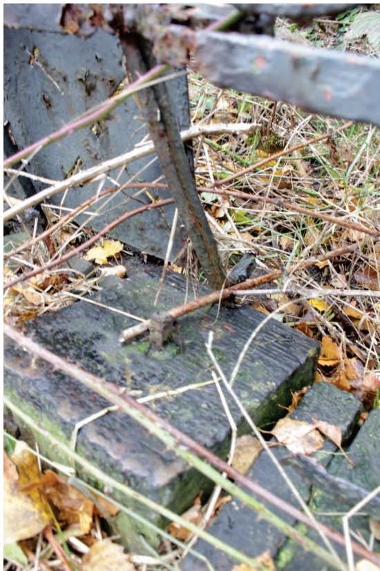
Abb. 11: Detail eines Sandsteinpostamentes mit Zaunstabrest
