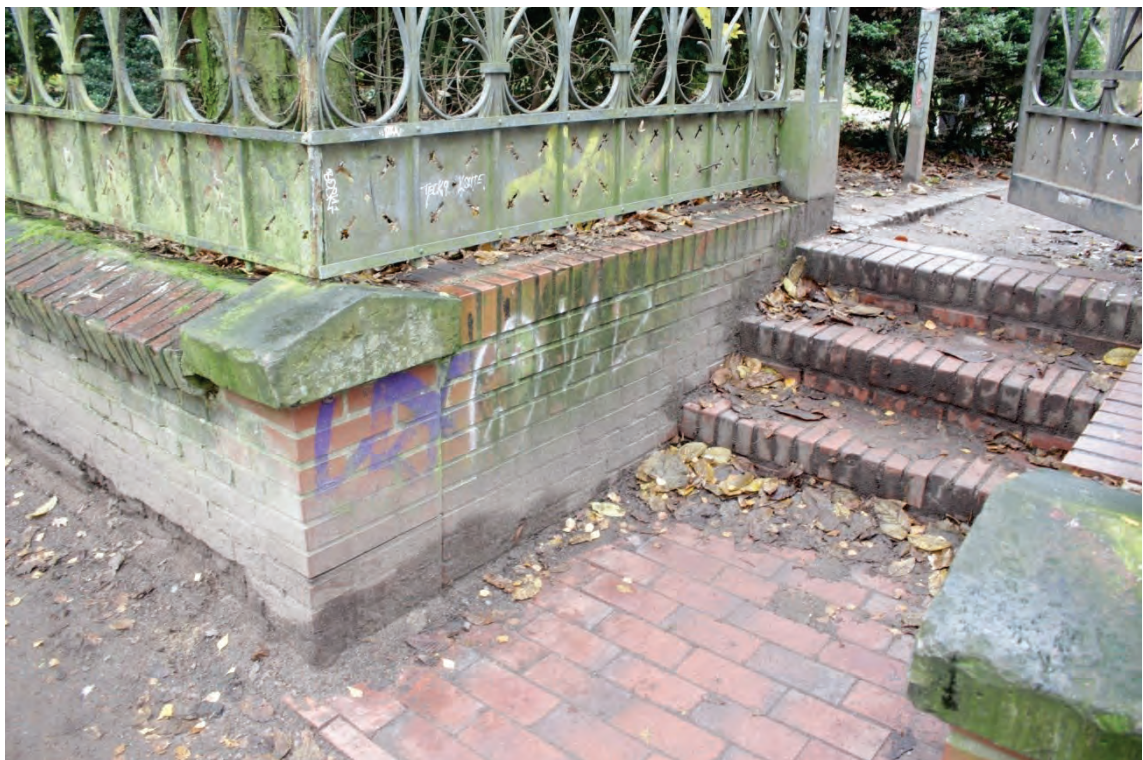
Abb. 58: Aufgang Tor 3 mit neuem Fundament
