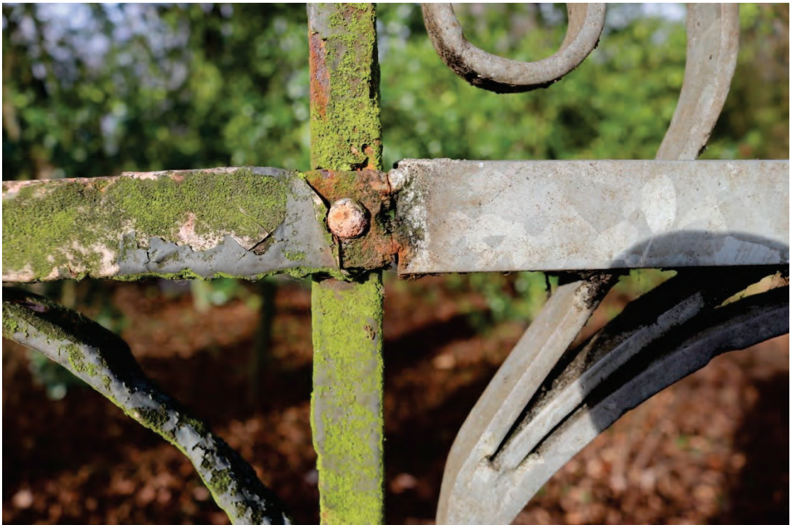
Abb. 134: geschweißter Übergang von historischem Zaun zur verzinkten Ergänzung
