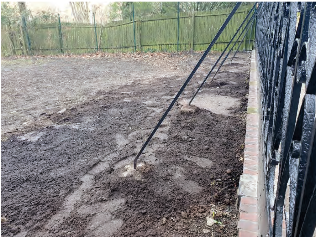
Abb. 42: Parkinnenseite mit neuen Punktfundamenten
