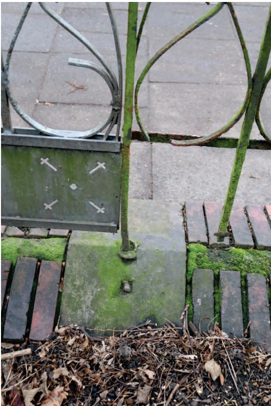
Abb. 32: Detail eines Sandsteinpostamentes mit fehlender Stütze
