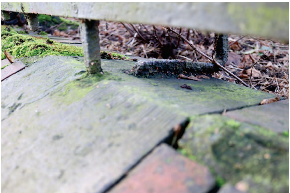
Abb. 26: Detail eines Sandsteinpostaments mit den Zaunbefestigungen
