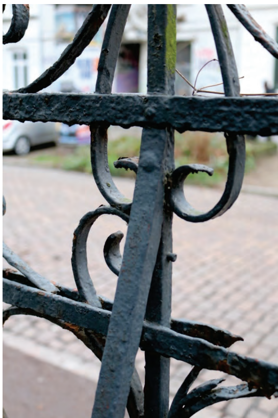
Abb. 140: Detail der historischen Stützenbefestigung
