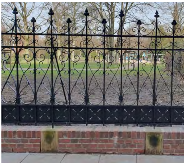
Foto der fertiggestellten Probeachse 2022, neuer Sockel, restaurierte Zaunelemente; Bezirksamt Altona
