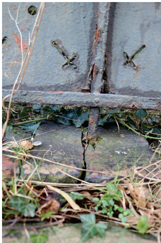
Abb. 12: Detail eines gespaltenen Sandsteinpostamentes mit Zaunstab
