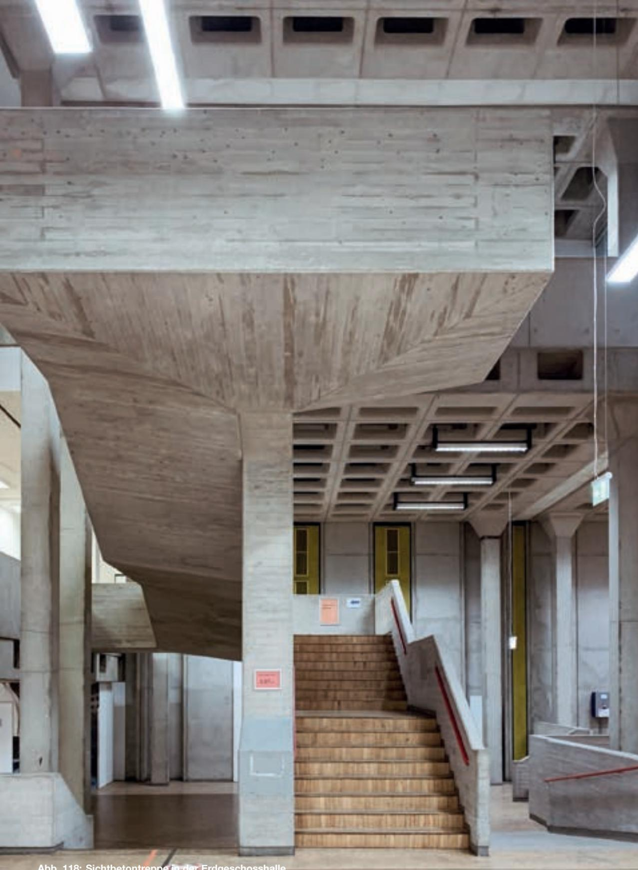
Abb. 118: Sichtbetontreppe in der Erdgeschosshalle.
