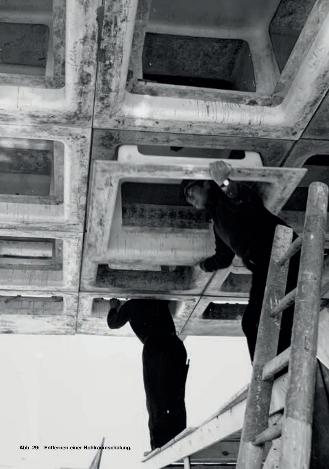
Abb. 29: Entfernen einer Hohlraumschalung.
