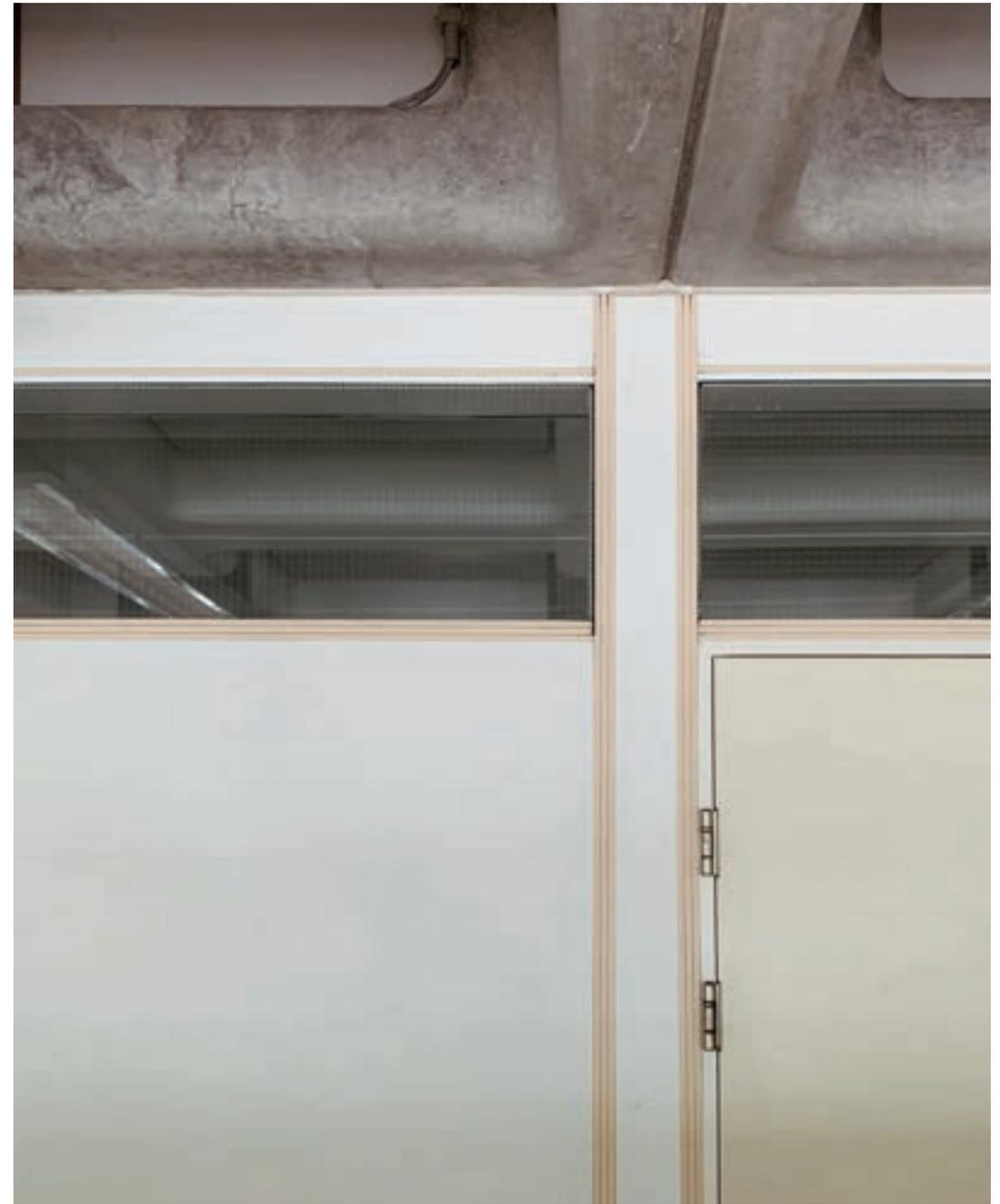
Abb. 89: Innenwandanschluss an Deckenkonstruktion.
