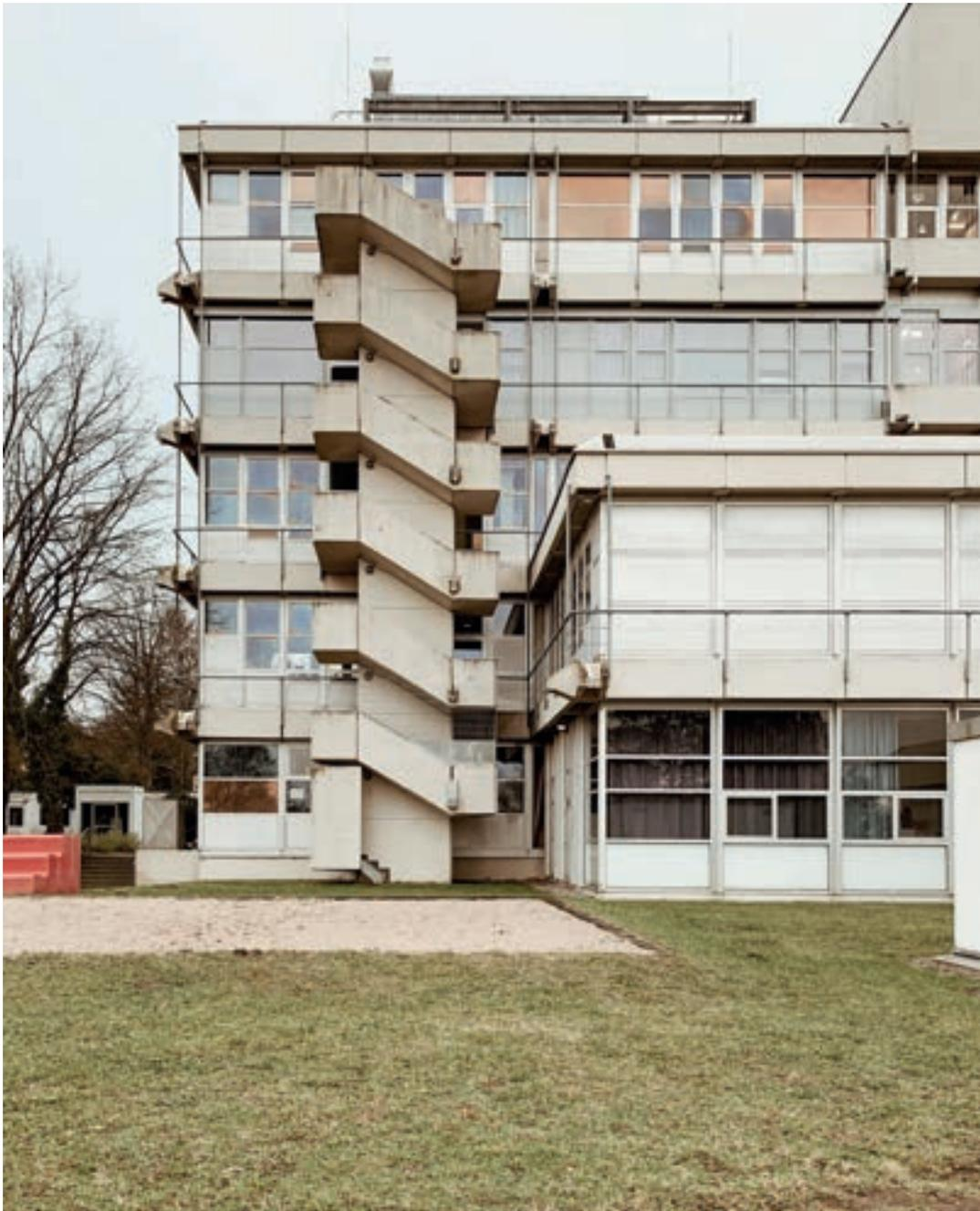
Abb. 60: Vorhangfassade mit Betonelementen.
