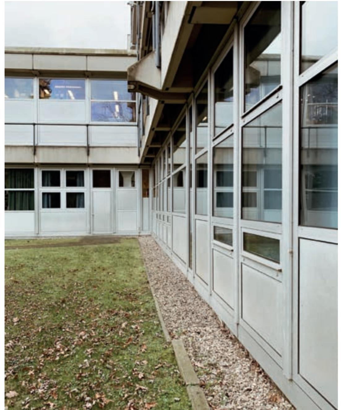
Abb. 85: Aluminiumfassade mit Verglasung und Paneelen.
