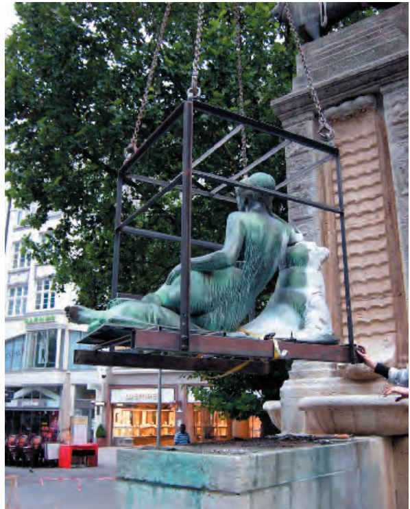
Abb. 2: Die Skulptur ‘Frau mit Seelöwe’ wird in einem dafür angefertigtem Gestell vom Sockel gehoben.
