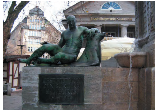
Abb. 11: Tafel1 mit der darüber montierten Figur, Zustand nach der Bearbeitung. Die Kalkkrusten wurden entfernt und die Tafel mit mikrokristallinem Wachs konserviert.
