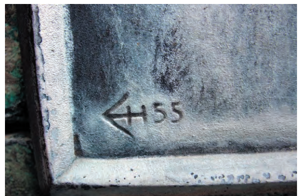
Abb. 52: Stiftertafel: Zustand vor der Restaurierung. Verkrustete Oberfläche.
