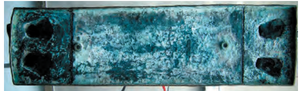
Abb. 23: Löwe: Blick in die Plinthe. Die Schweißverbindungen sind intakt.
