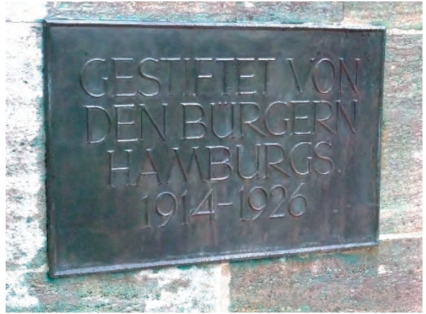
Abb. 53: Stifertafel: Zustand nach der Restaurierung.
