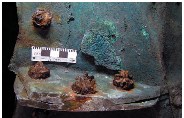
Abb. 25: Mann: Blick in die Innenkonstruktion: Schrauben sind weitgehend korrodiert.
