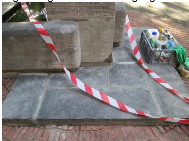
Neuverfugung Sockelplatte
