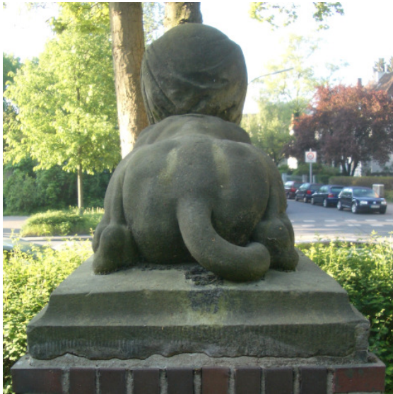
Sphinx 1 Vorzustand Rückseite.
