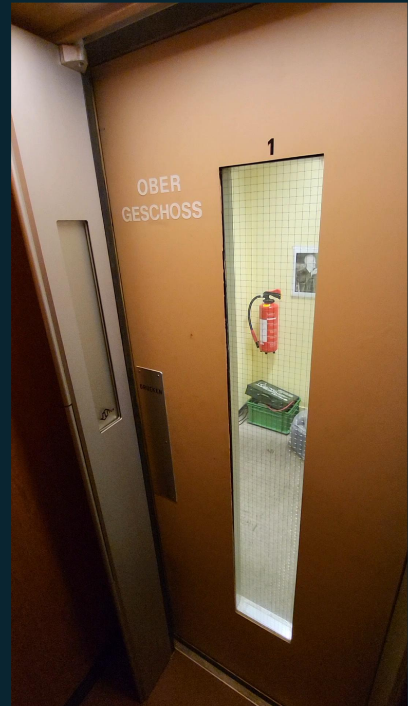
Mitfahrt mit nachgerüsteter Fahrkorbtür
