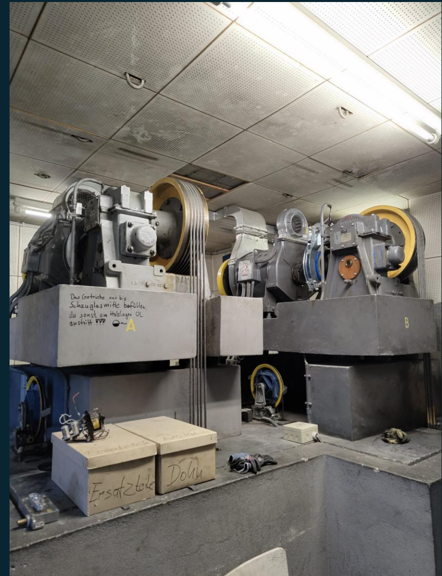
Motoren und Getriebe auf gummigelagerten Betonsockeln
