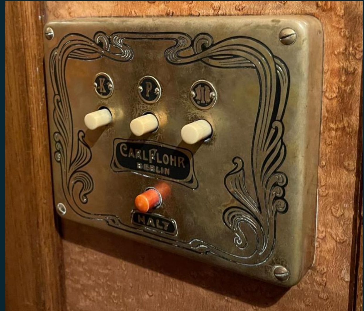
Bedientableau für einen Personenaufzug mit Drucktastern aus Celluloseacetat, Flohr (1909)
