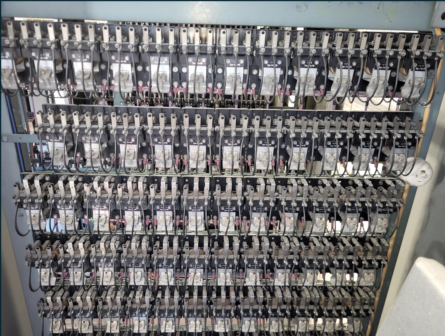
Detail der bauzeitlichen Sammelsteuerung
